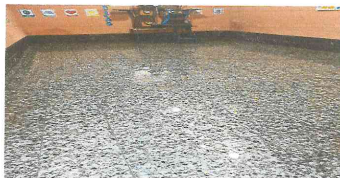
Foto 2: sustitucion de piso aula 1
