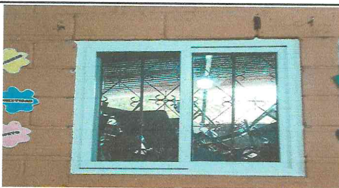
Foto 5: sustitucion de ventanas aula 1
