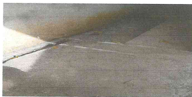
Foto 4: sustitucion de losa de patio
