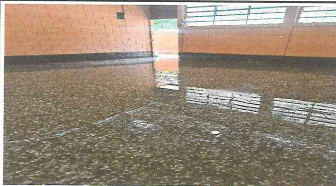
Foto1: sustitucion de piso aula 2
