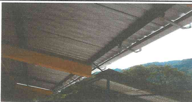
Foto 6: sustitucion de canales de bajada de agua.
