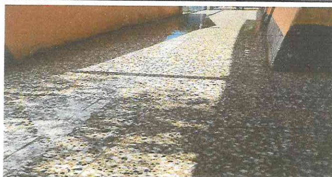
Foto 3: sustitucion de piso corredor
